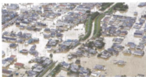
西日本豪雨で大規模浸水した岡山県倉敷市真備町地区。逃げ遅れで多数の犠牲者が出た(昨年7月8日)
